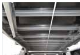
Massive Konstruktion des Rahmens
